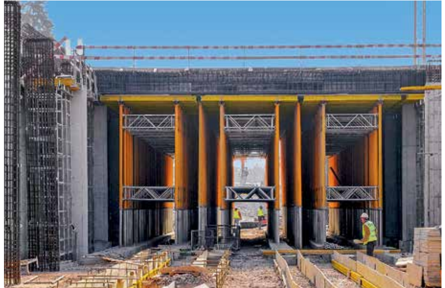
En présence de dalles hautes surtout, les tours d'étalement MULTIPROP sont une alternative économique aux échafaudages classiques.
