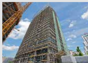
Echafaudages de façades
