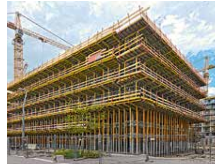
La solution PERI, constituée des systèmes MULTIPROP et MULTIFLEX, était destinée au coffrage des balcons ; elle servait parallèlement de console de travail.
