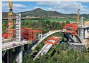
Coffrages de ponts
