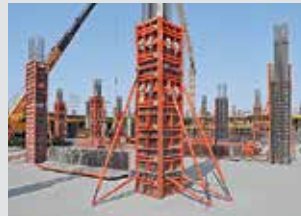
Coffrages de poteaux
