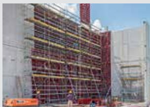
Echafaudages de ferrailage
