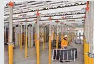
Coffrages de dalles
