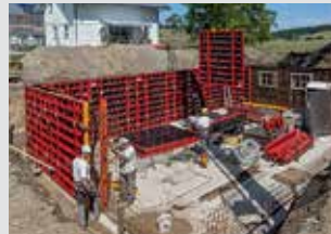
Coffrages de voiles
