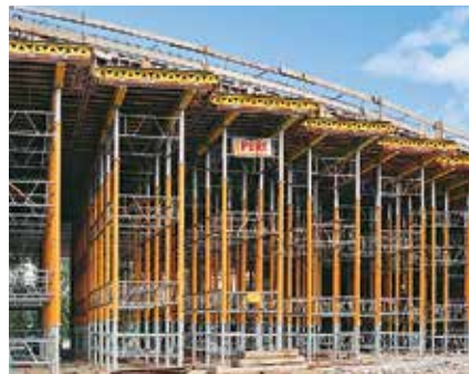
Tours d'étalement MULTIPROP comme soubassement pour tables de coffrage spécifiques.
