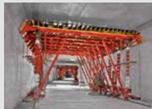
Coffrages de tunnels
