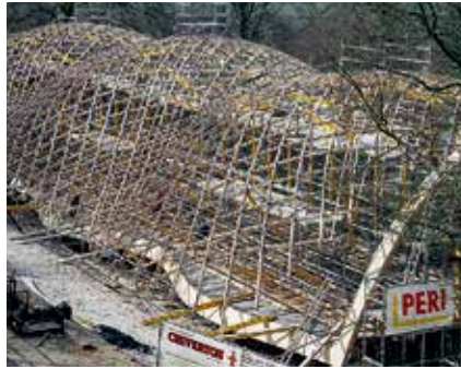
Les étais MULTIPROP soutenaient la structure en bois et donnaient une forme incurvée à la coque en treillis.
