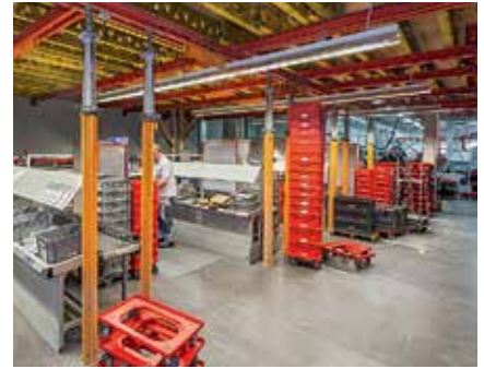
Solution d'étalement peu coûteuse constituée d'étais MULTIPROP en combinaison avec des éléments standard VARIOKIT.
