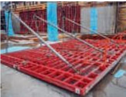
Montage facile et sécuritaire d'étais de réglage et de contre-flèches sur un coffrage positionné horizontalement...
