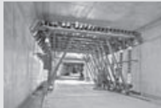
Coffrage de Tunnel
