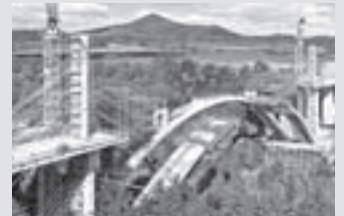
Coffrage de Pont
