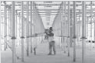
Coffrage de Dalle
