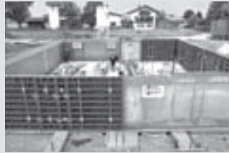
Coffrage de Mur
