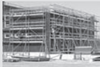
Échafaudage de Chantier
