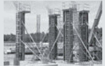
Coffrage de Colonnes
