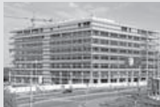
Échafaudage de Façade
