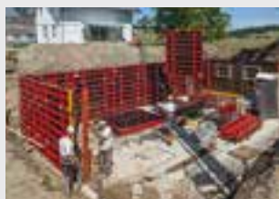
Coffrages de voiles
