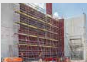
Echafaudages de ferrailage
