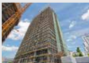
Echafaudages de façades
