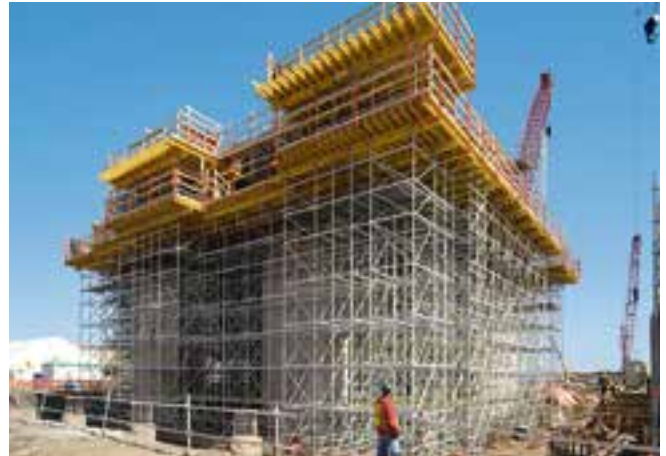
PERI UP Rosett et MULTIFLEX ont permis la reprise en toute fiabilité, par le sol, des hautes charges exercées par les composants massifs à des hauteurs comprises entre 10 m et 12 m.
