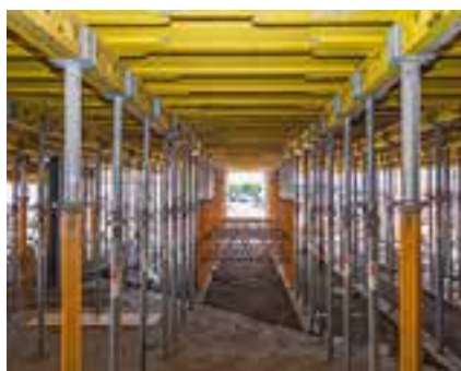
L'utilisation de la poutrelle GT 24 a pour effet de réduire le nombre de poutrelles, de membrures en acier ou d'étais de dalle. Il en résulte des économies de matériel et de main d'œuvre.
