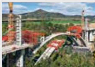
Coffrages de ponts
