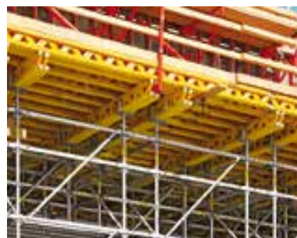
L'utilisation de la poutrelle GT 24, en tant que primaire double en liaison avec un étaielement PERI UP Rosett Flex, permet la reprise de charges élevées sur de grandes hauteurs.
