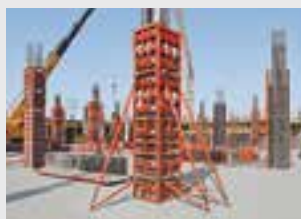
Coffrages de poteaux
