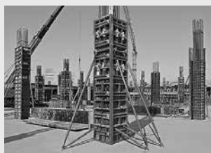
Coffrage de colonnes
