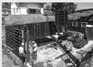
Coffrage de mur
