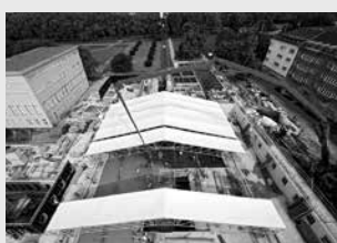
Échafaudage de protection
