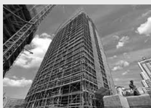
Échafaudage de façade
