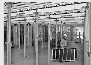
Coffrage de dalle
