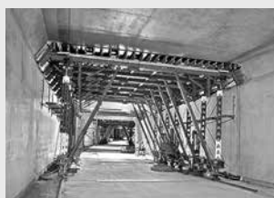
Coffrage de tunnel
