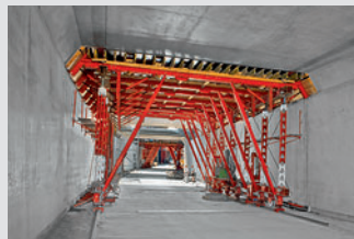
Coffrage de tunnel
