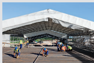
Échafaudage de protection
