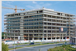
Échafaudage de façade
