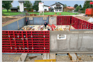
Coffrage de mur
