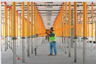
Coffrage de dalle
