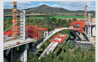
Coffrage de pont
