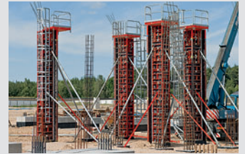
Coffrage de colonnes
