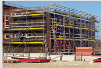
Échafaudage de chantier
