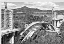
Coffrages de ponts
