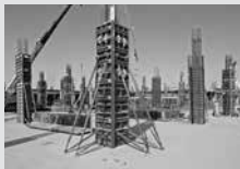
Coffrages de poteaux
