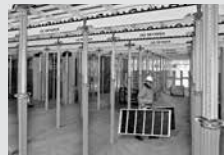
Coffrages de dalles
