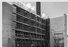
Echafaudages de ferrillage
