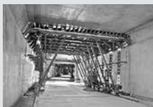
Coffrages de tunnels
