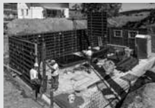
Coffrages de voiles
