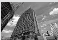
Echafaudages de façades
