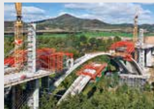
Coffrage de pont
