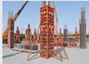
Coffrage de colonnes
