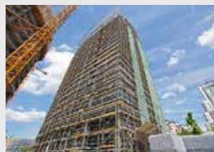
Échafaudage de façade
