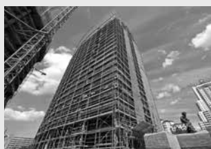
Echafaudages de façades
