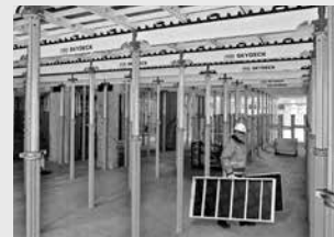
Coffrages de dalles
