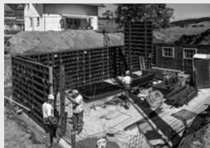
Coffrages de voiles
