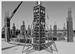
Coffrages de poteaux
