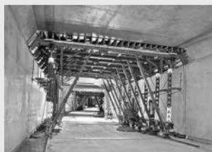
Coffrages de tunnels
