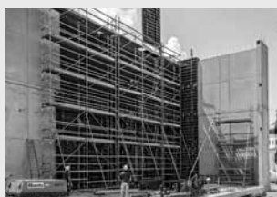
Echafaudages de ferrailage
